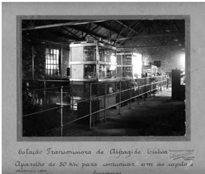
CASA DAS MÁQUINAS, QUADRO DE DISTRIBUIÇÃO E BASTIDORES DE ALIMENTAÇÃO DOS EMISSORES CUX, 1926. ACPRM
