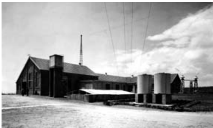
ASPECTO EXTERIOR DO EDIFÍCIO DA ESTAÇÃO DE ALFRAGIDE, LISBOA. ACPRM
